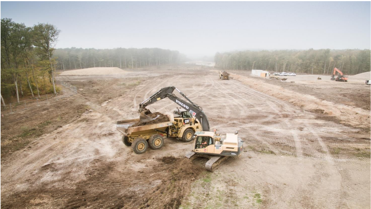
Figure 4 : Photo du chantier dans la Forêt d'Évreux (à ce jour, la tranchée dans la forêt d'Évreux n'a quasiment pas été replantée) (source : site internet du projet www.deviation-evreux.fr/phototheque )
